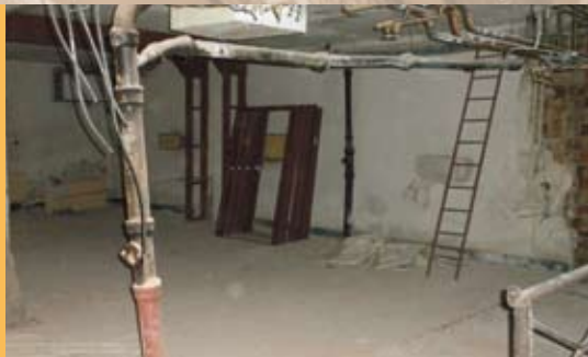
Strojovna vzduchotechniky ve výstavbě
