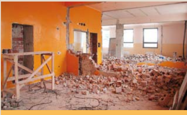
Výstavba dospávacího pokoje
