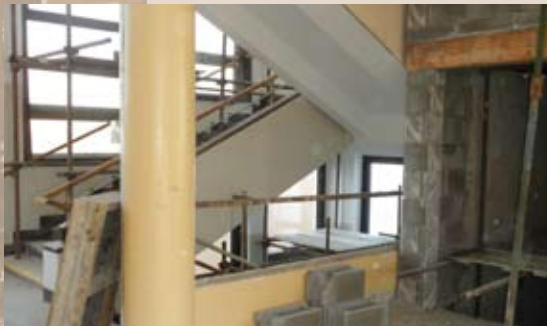
Výtah ve výstavbě
