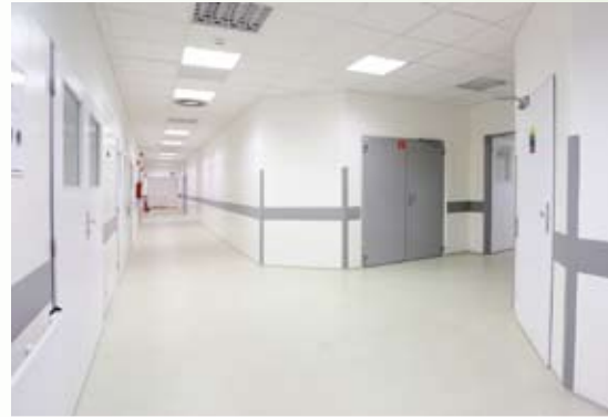
Ambulance - obslužná chodba
